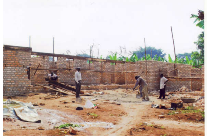
Huisjes in aanbouw, mede betaald uit de opbrengst van de collecte afgelopen Februari in de Dominicuskerk te Amsterdam
